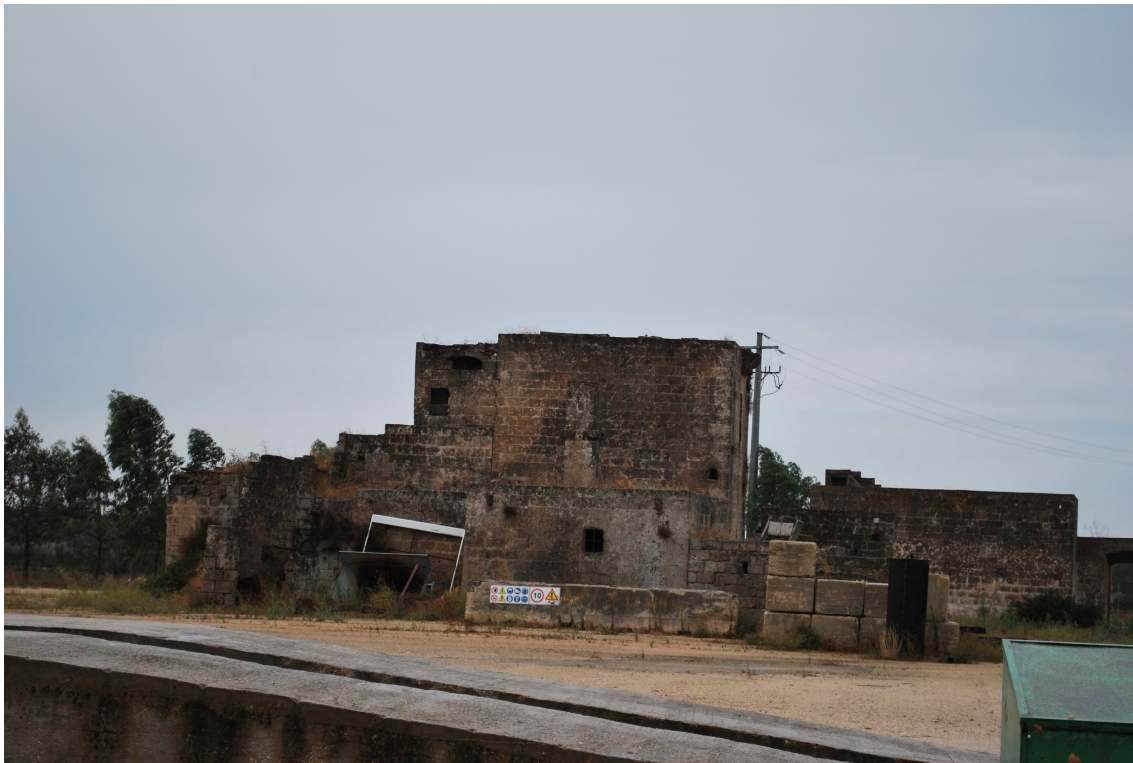
Figura 73 - Masseria abbandonata esistente in prossimità dell'impianto
